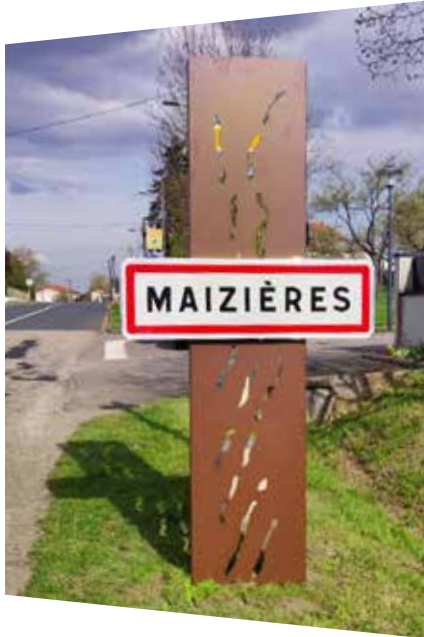
Pose de totems modernes d'entrée de village
