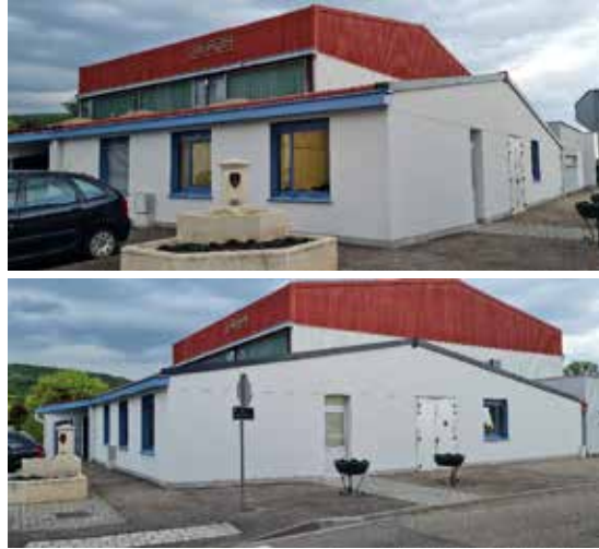
Rénovation des façades de la salle polyvalente
