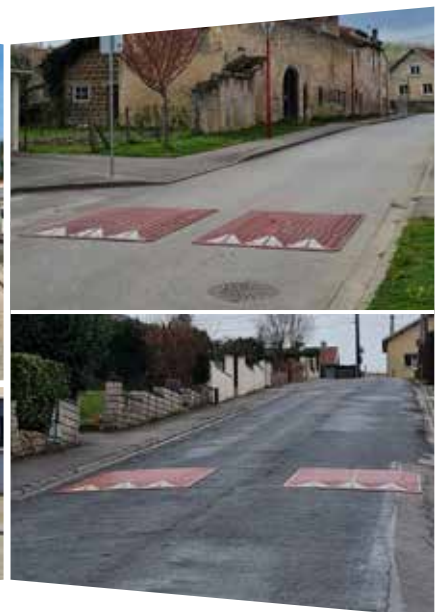
Pose de cousins berlinois rue de Xeuilley et rue des Champs Celleux
