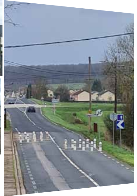
Mise en place de chicanes entrée Nord du village
